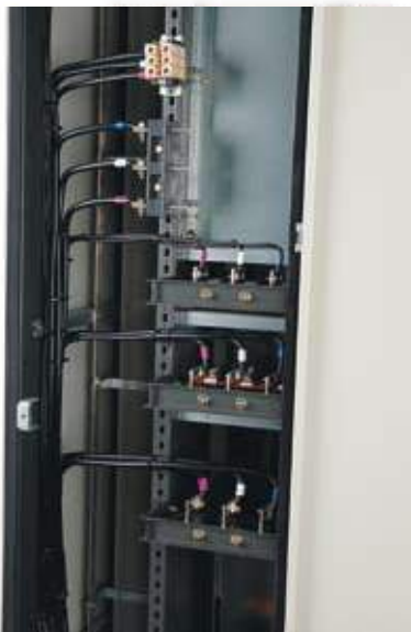
Conexion de los cables de fuerza y mando
